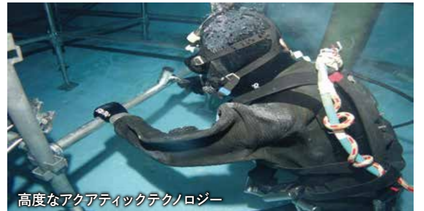
ダム等における潜水工事実績多数
