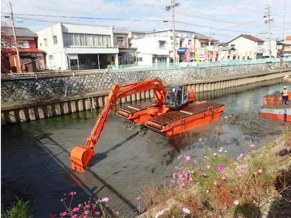
小規模な河川工事、埋立工事、地盤改良工事に能力を発揮します。
