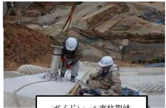
ガイドレール支柱取付
