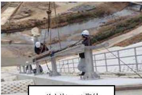
ガイドレール取付
