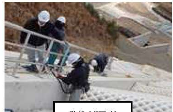
階段手摺取付
