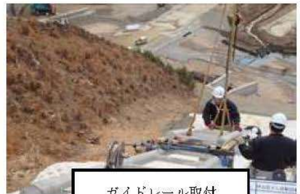
ガイドレール取付
