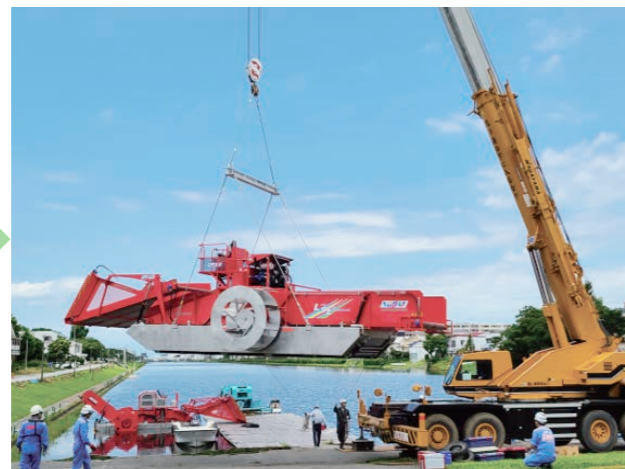
ラフテレーンクレーンを用いて水面へ搬入します。
