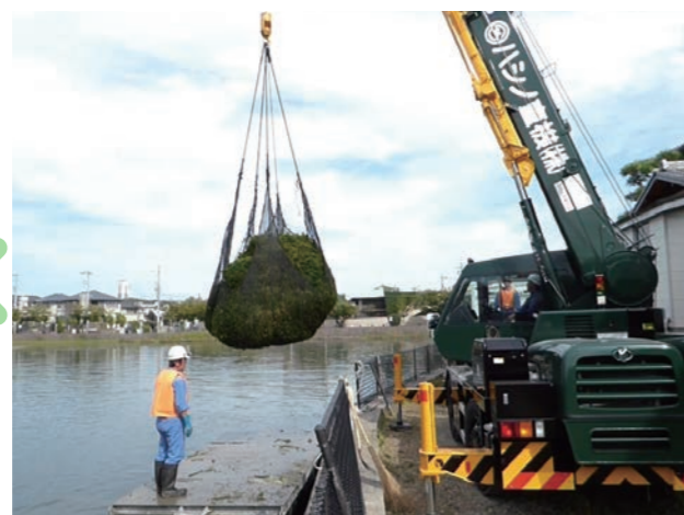
ロープモックをクレーンで陸揚げします。
