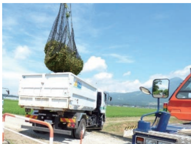
ダンプトラック等で処分場へ運搬します。
