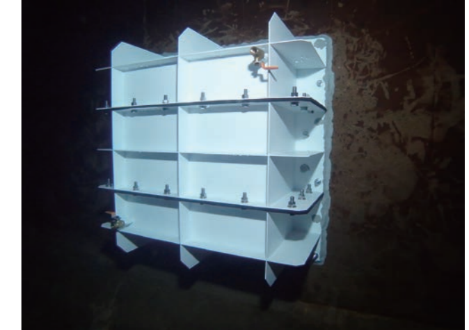
配水池外部に設置されているバルブの更新や管路工事の際、一時的に水の流れを遮る必要がある時に槽内に止水板を設置します。
