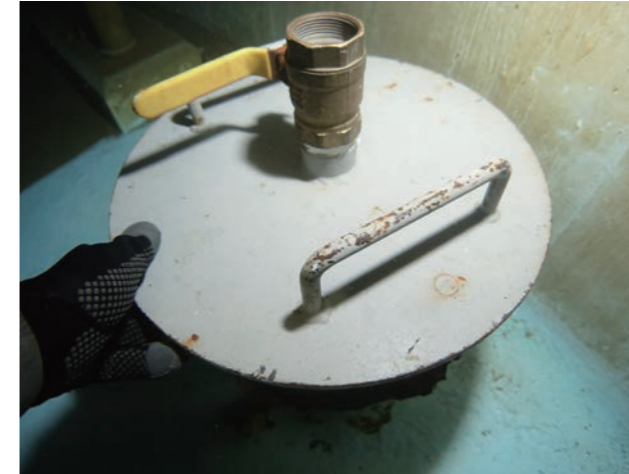
配水池外部に設置されているバルブの更新や管路工事の際、一時的に水の流れを遮る必要がある時に槽内に止水板を設置します。
