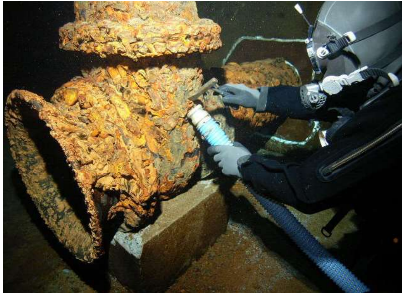
不断水工法によるバルブ交換
