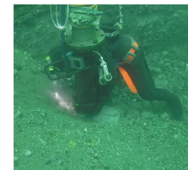
水中浚渫 エアリフト工法
