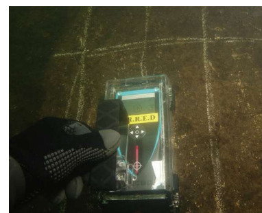
水中鉄筋探査
